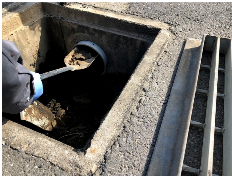
d. 横引き配管内の堆積物処理
