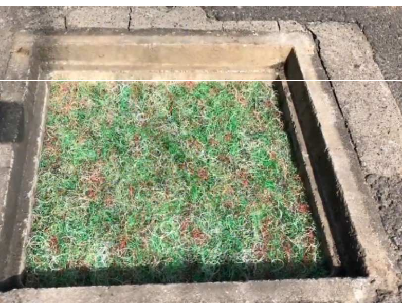
i. 天端よりー20mmで高さ調整
