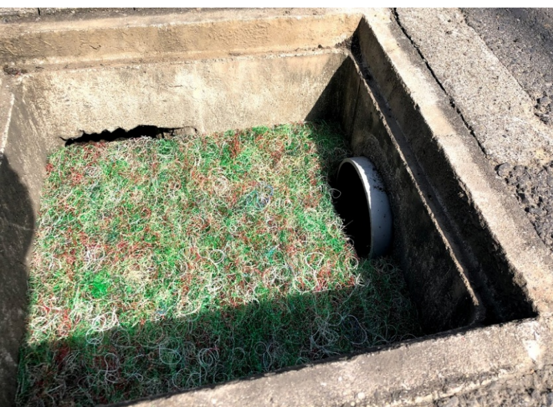
h. カールマット雨水枳の深さ分敷設
