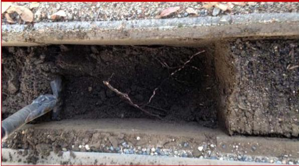
←赤枠C写真:従来の技術では細砂と泥が底から堆積し、U字溝は機能して無い。分別集水マットを敷設することで水の流れる底面が確保できる。↓青枠D写真
