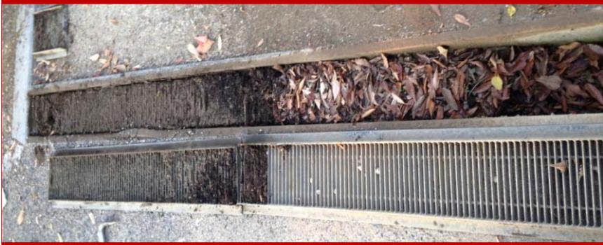
泥や砂の入り易い場所では分別集水マットとグレーチングの間に、細砂と泥が堆積し、湿乾を繰り返すと目詰まりしますので、雨が止んだ後に、グレーチングからかき出すように清掃することで能力維持期間が延びる
