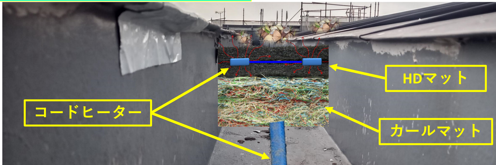
写真左：スノーダクト用のコードヒーターの電源を入れて置けばHDマットの上に雪が積もり難い
