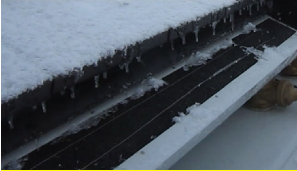
写真左：スノーダクト用のコードヒーターの電源を入れて置けばHDマットの上に雪が積もり難い
