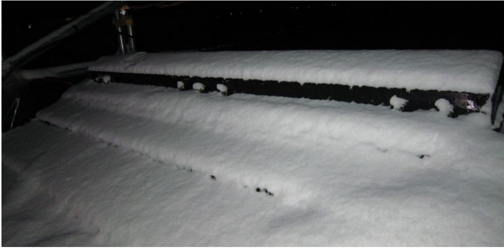
①棟ヒーター、水切りヒーターOFF
