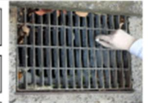
新技術では雨水桧、U字溝内の堆積物処理工程が初回の1回【新設では不要】と成る: 処理コストの削減
